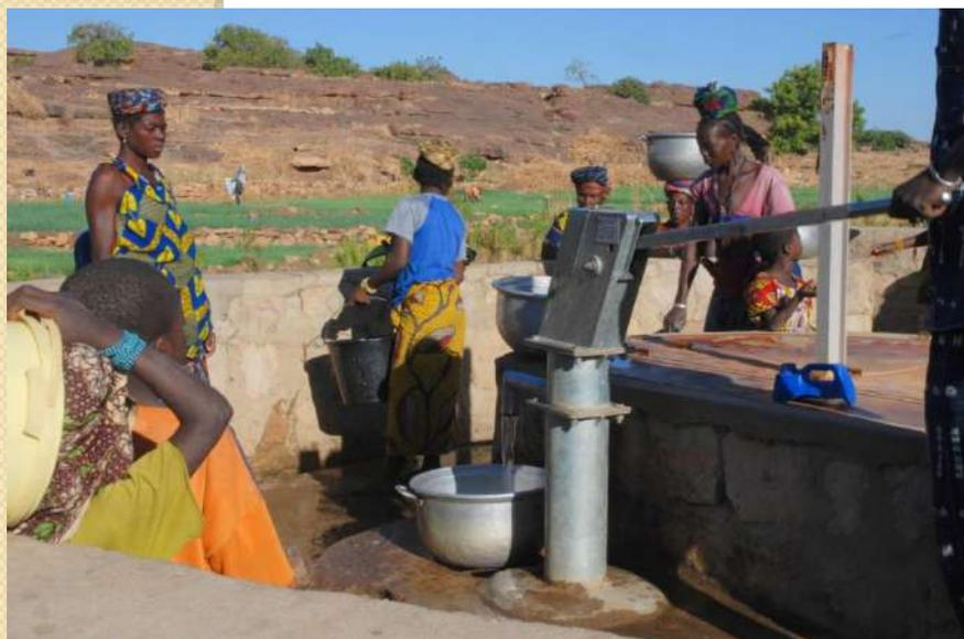
Puits obturés en partie supérieure et équipés de pompe manuelle pour éviter la pollution de l'eau
