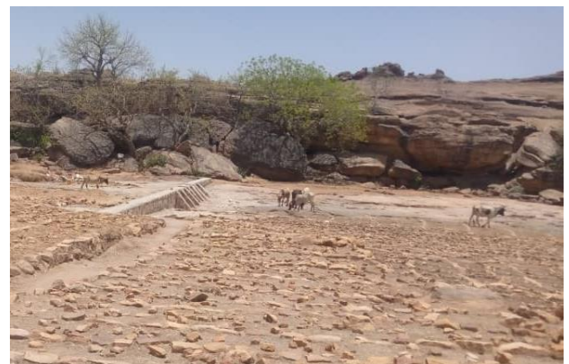
Barrage de Ama Kognon (fin de construction en juillet 2022)
