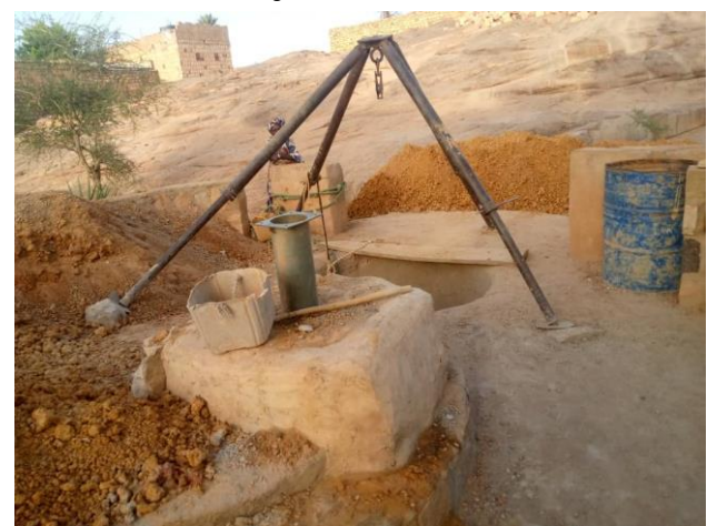
Nouveau puits eau potable Sangha Mission en cours de construction
