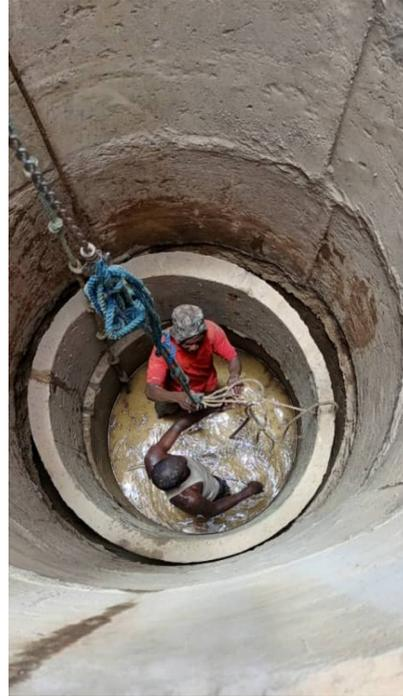
**Août 2024 (saison des pluies) – creusement du puits achevé, reste à bâtir la zone de propreté, et à installer la tête du puits (dalle de protection et pompe)**
